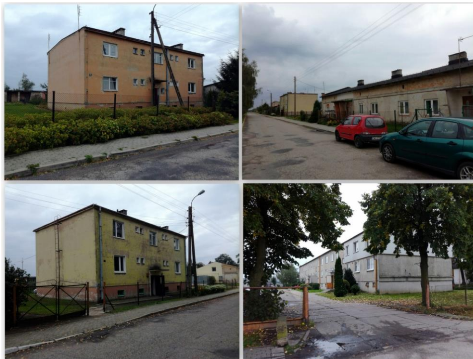
Rysunek 9. Stan techniczny budynków mieszkalnych w Choceniu
