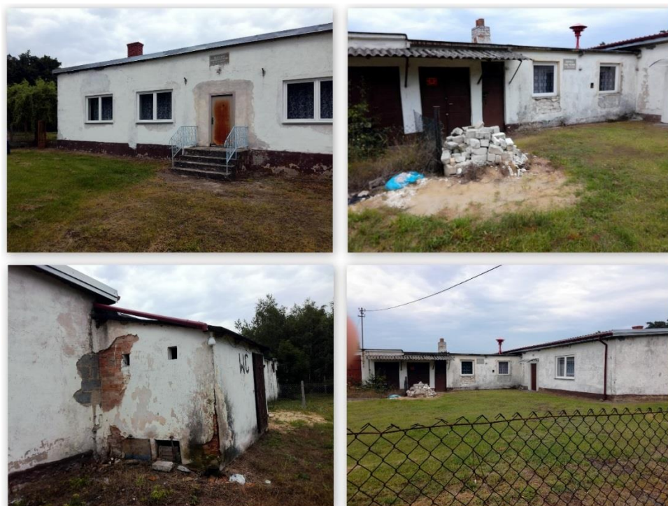
Rysunek 11. Świetlica wiejska w Szczutkowie
